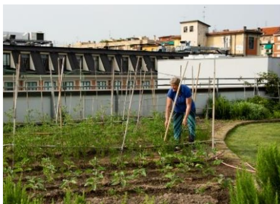
Tetto intensivo con orto di Superstudiopiù a Milano
