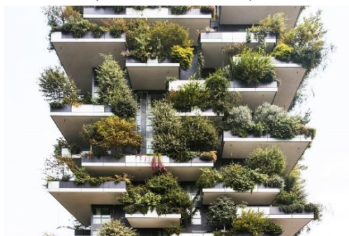
Verde di balconata Bosco Verticale a Milano (edificio residenziale)
